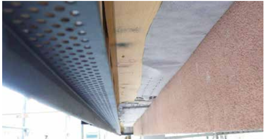
Allineamento facciata prefabbricata
