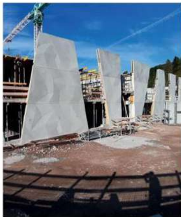
Fabbrica della pasta Felicetti Costruzione con elementi prefabbricati di Progress Spa
