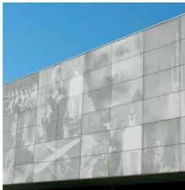
Calcestruzzo e design Grande libertà creativa
