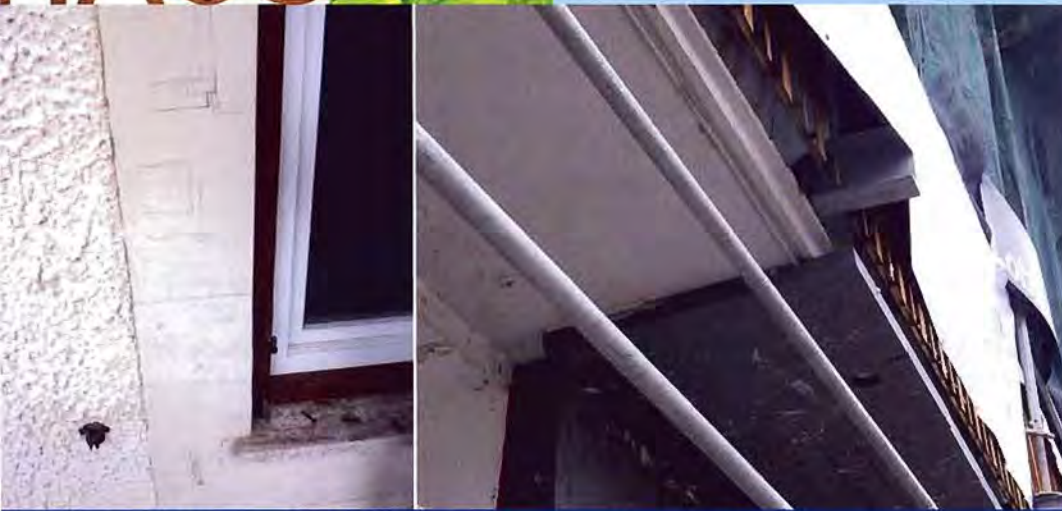
Eine energetische Sanierung erfordert eine komplexe Planung, die auf einer genauen Analyse des Baues und seiner Schwachstellen aufbaut. Meist müssen Fenster ausgetauscht und Außenmauern gedämmt werden.
