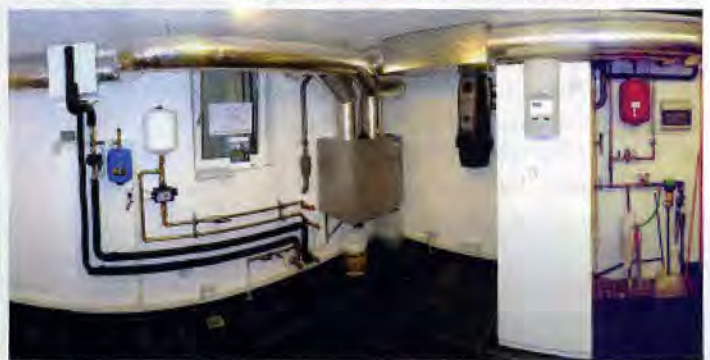
Blick nach Süden: Terrasse des Hauses „Röhr“ in Verdings (links). In der Sonne: Panoramafenster lassen Wärme ins Haus, der Raffstore bewahrt vor zu großer Hitze (ganz oben). Das Herz des Passivhauses: Im Heizungskeller dreht sich alles um die Energie (oben).
